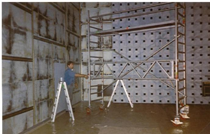
Abb.2: Demontage von festverklebten Pyramidenabsorber
