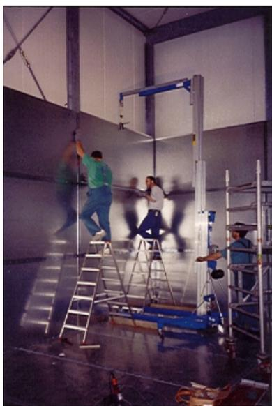
Abb.1: Abgeschirmte Kabine bei der Remontage
